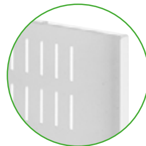
otwory w drzwiach umożliwiające zarówno wentylację instalacji jak i swobodny przepływ fal WiFi na zewnątrz rozdzielnicy
