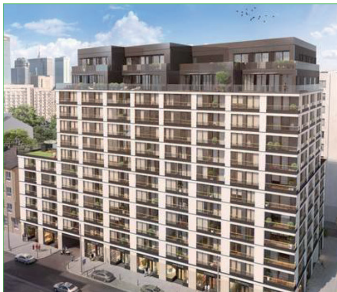
Apartamenty Ogrodowa – Warszawa
